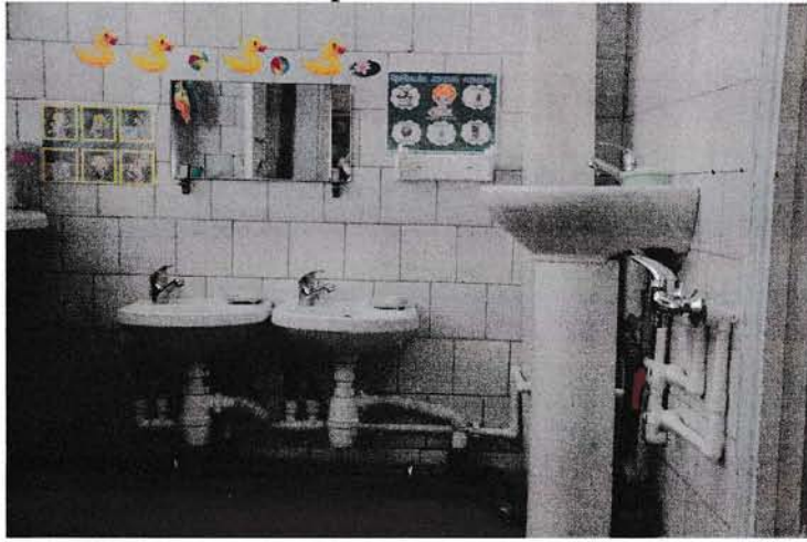
Фото № 6-7: Санитарно-гигиеническое помещение:
